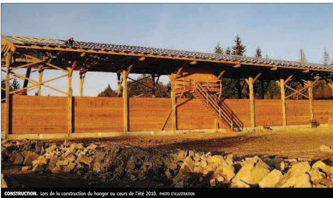
CONSTRUCTION. Lors de la construction du hangar au cours de l'été 2010. PHOTO D'ILLUSTRATION
